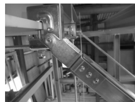
斜め補強材取り付け金物
