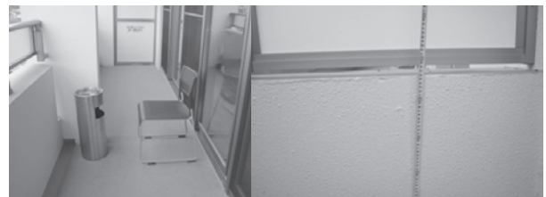
写真10：緊急壁（写真奥） 写真11：非常階段との段差
