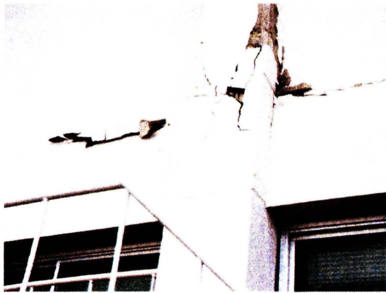
写真7 南面2階中柱の被害
