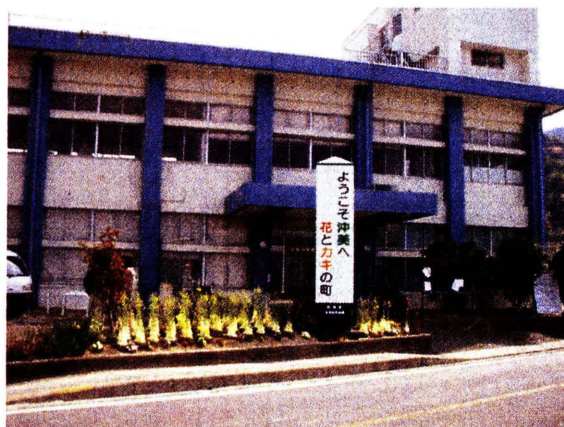
写真2 三高支所庁舎
