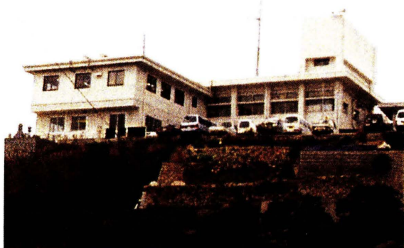
写真1 沖美町庁舎全景
