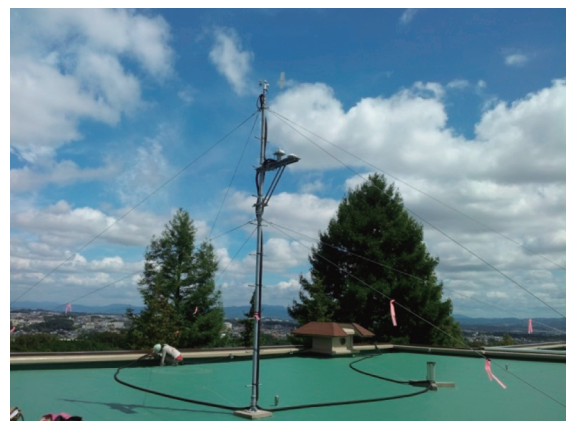
写真1 移設後の気象観測塔
