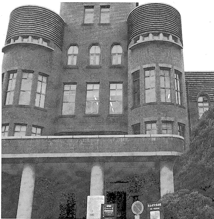
大学文書館が一階と二階に入っている旧工学部本館
