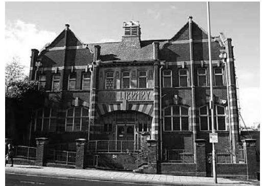
バーミンガム大学近辺の地区の図書館。1900年頃に建てられたもので、地域住民の団体が運営している。
