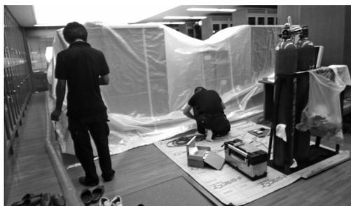
4) 濃度計で計測しながら二酸化炭素を注入
