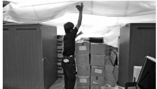
3) 大型資料用のスライド式収納棚を四隅に配置して、それを支柱としてテント（約70立方メートル）を設置
