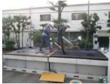
図3 アスファルト舗設状況
