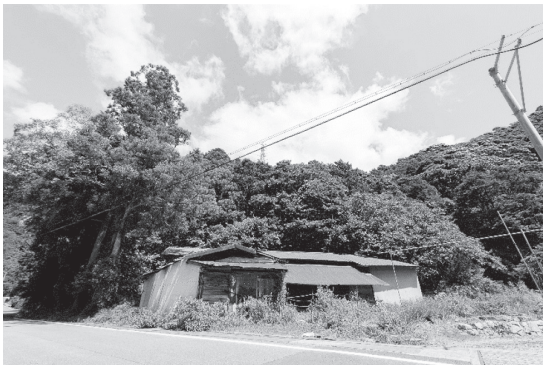
写真2 現在のすさみ線香水車の外観（2020年撮影）
