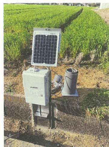
写真-1 IoT 水門の設置状況
