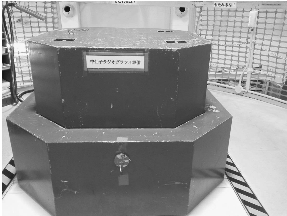
図 1. 原子炉設備における試料照射場所
