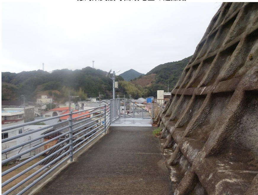
徳島県美波町由岐地区の避難路
