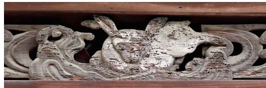
⑦1 広陵町中 徳浄寺の欄間透かし彫り
