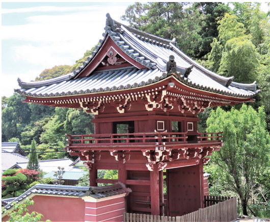
⑨ 奥院鐘楼門 入母屋造りの屋根に10個の鬼瓦
