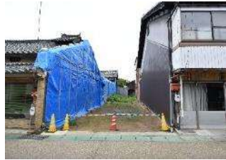
写真2 町家が解体され歯抜け状態となり景観の破壊が進む旧町
