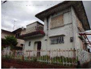
写真1 宅地開発された地域で増加している空き家住宅
