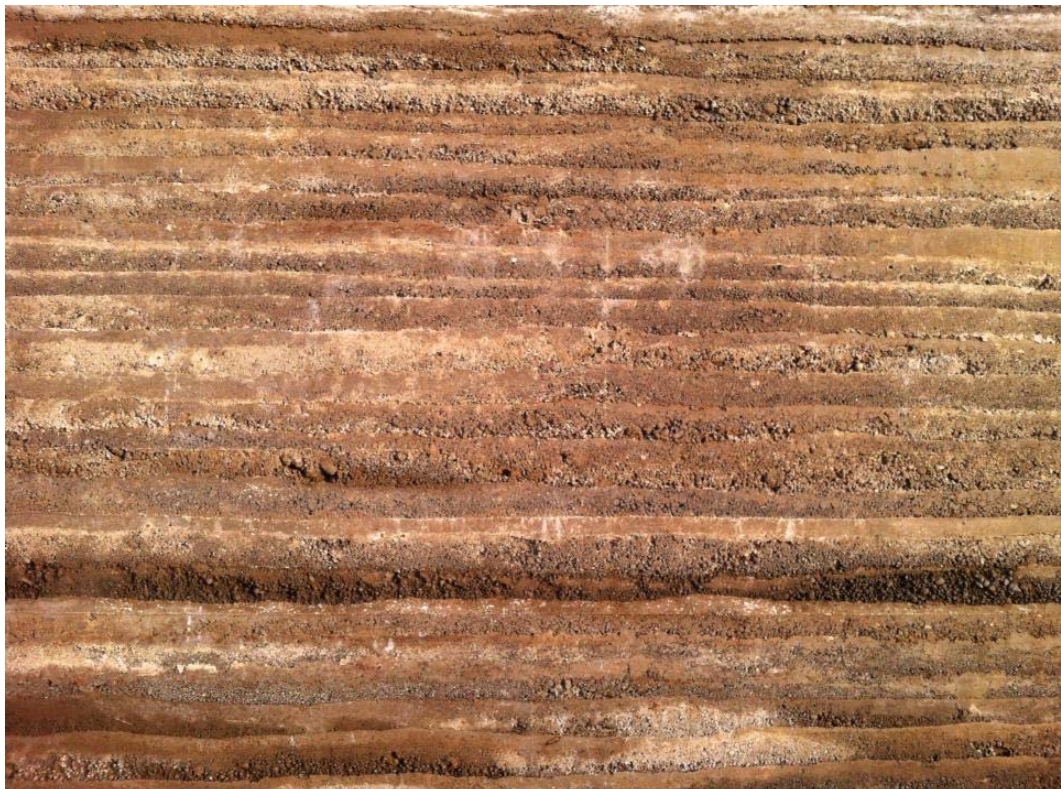
写真 2.2.1 版築壁面
