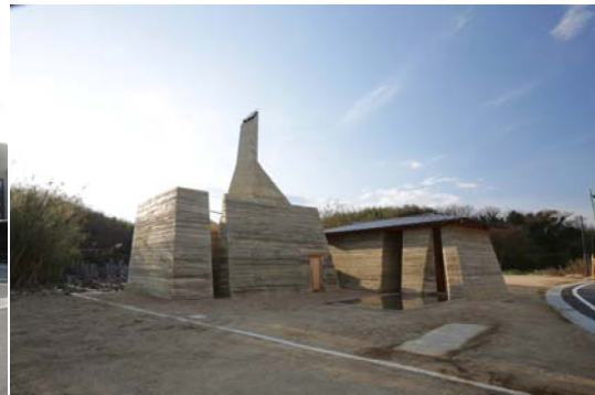
写真 1.3.2 オーガニック建築 (無垢・生成りの素材感を持った建築)
