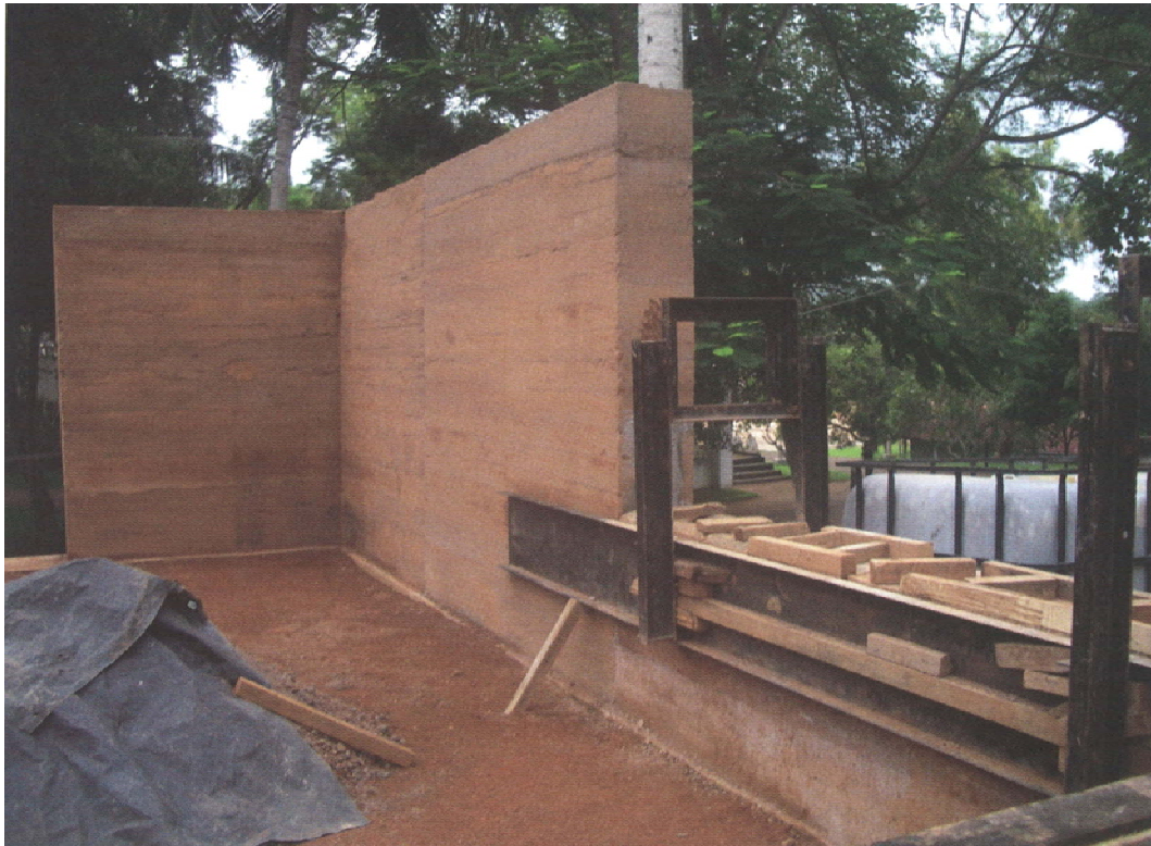
写真 5.1.2 カニバサミ工法施工例 (ゲルノート・ミンケ「土・建築・環境 エコ時代の再発見」より引用)
