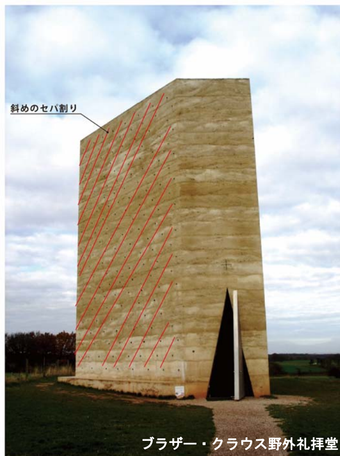
写真 1. 3. 9 版築土の有機性をコントロールする例
