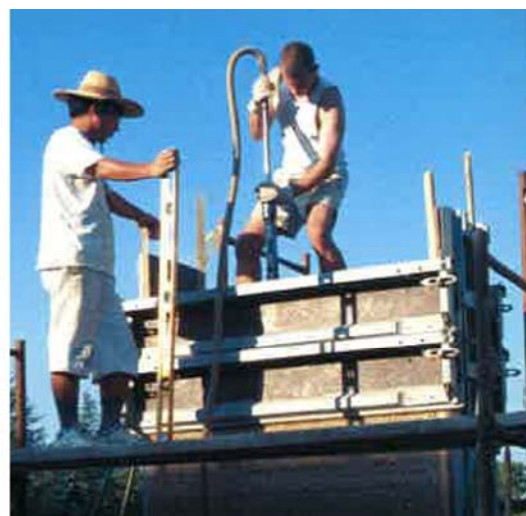
写真 2.0.2 古来より伝わる版築工法の様子 2
