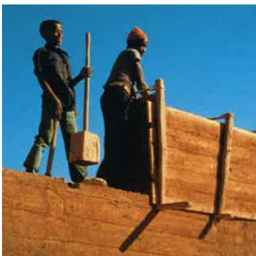
写真 2.0.1 古来より伝わる版築工法の様子 1
