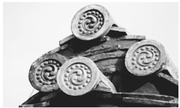
図9 対馬市巖原町の民家大棟端
