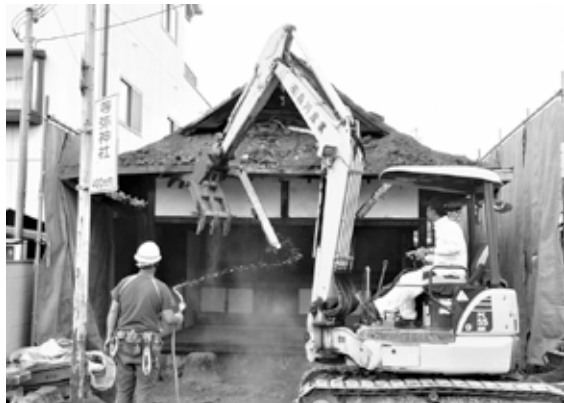
図76 薬師庵解体 2014年5月22日
