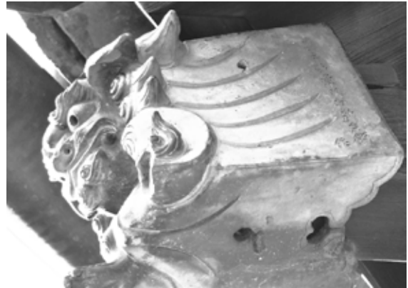
図88 獅子をあらわす隅木蓋瓦 「常門村 瓦師 新兵衛作 奥瓦治」 橿原市南浦町 法然寺
