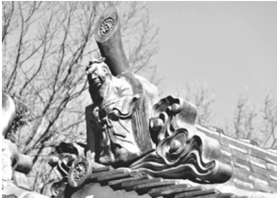
図87 鍾馗像 「山瓦宗 (常門瓦新作)」 嘉永5年 (1852) 明日香村祝戸 民家
