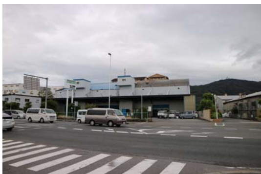
(a)被災建物 A 外観
