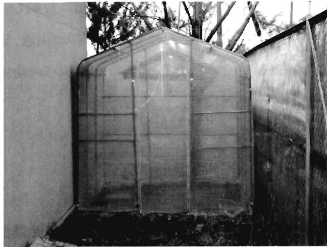
図 17. 家庭園芸用小型ビニール温室
