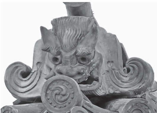
図 57 同隅棟の鬼瓦 宝永元年 (1704)
