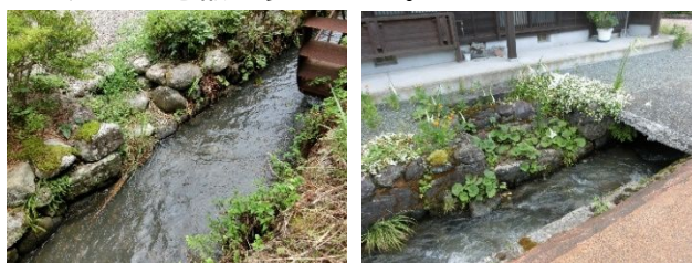
写真4 熊川宿の水利用施設の一例
