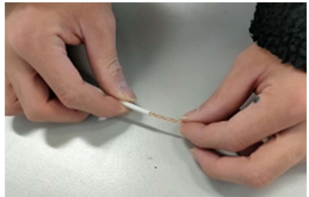
図7. IV線が真っ直ぐで短い場合、ミシン目を入れずに被覆を剥ぐことができる。
