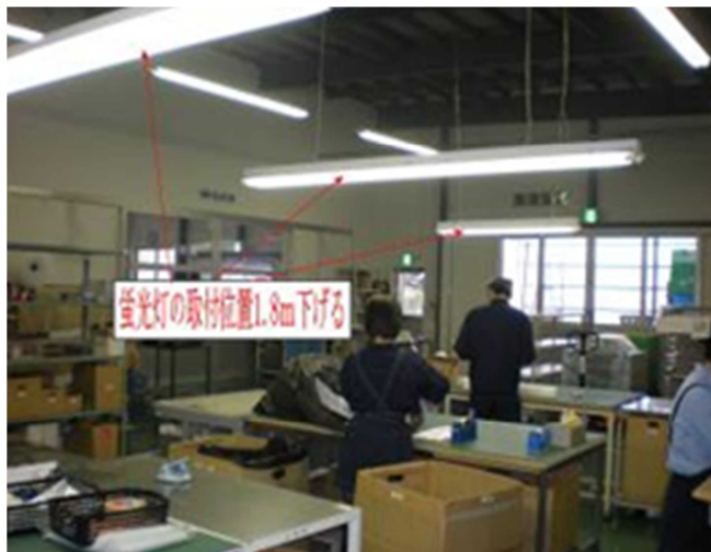
図 3.48 蛍光灯の取付位置の引き下げ
