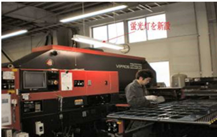
図 3.47 蛍光灯の新設
