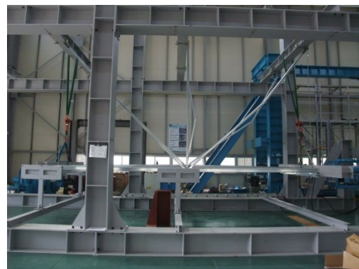
写真 4 モデル 4 の終局状況 (部材の座屈)
