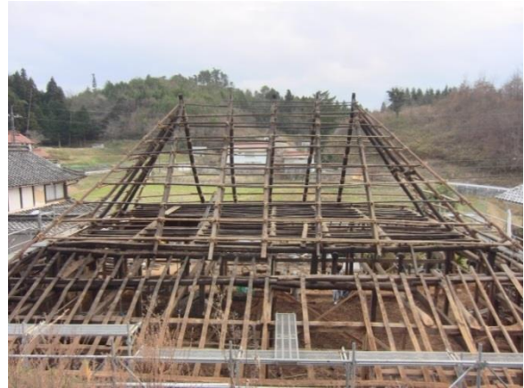
写真1 茅をはがした茅葺き屋根構造体
