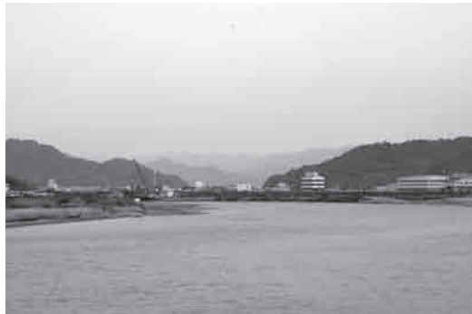
写真 12-1 安諦橋から有田川上流を望む（有田市、2017年3月）
