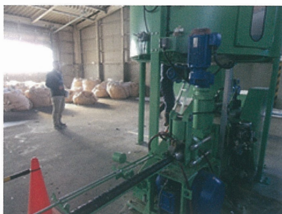
写真2 打ち出し式固形燃料製造装置
