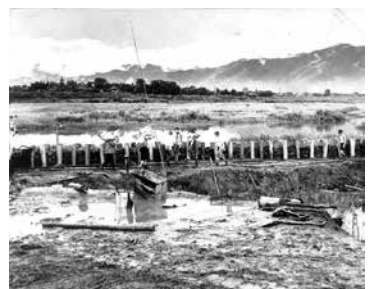
写真6 決壊した堤防の締め切り作業現場。後方は木屋瀬方面 (松尾さん撮影)
