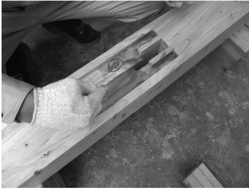
写真 10. 試験体 3 施工風景
