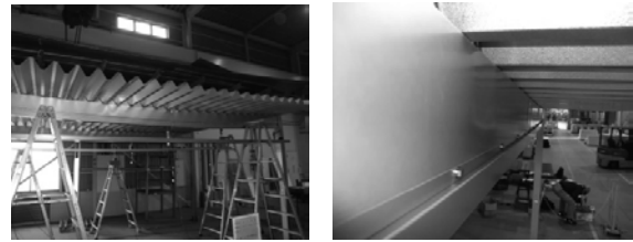
写真 11 最終載荷状況と除荷後残留変形
