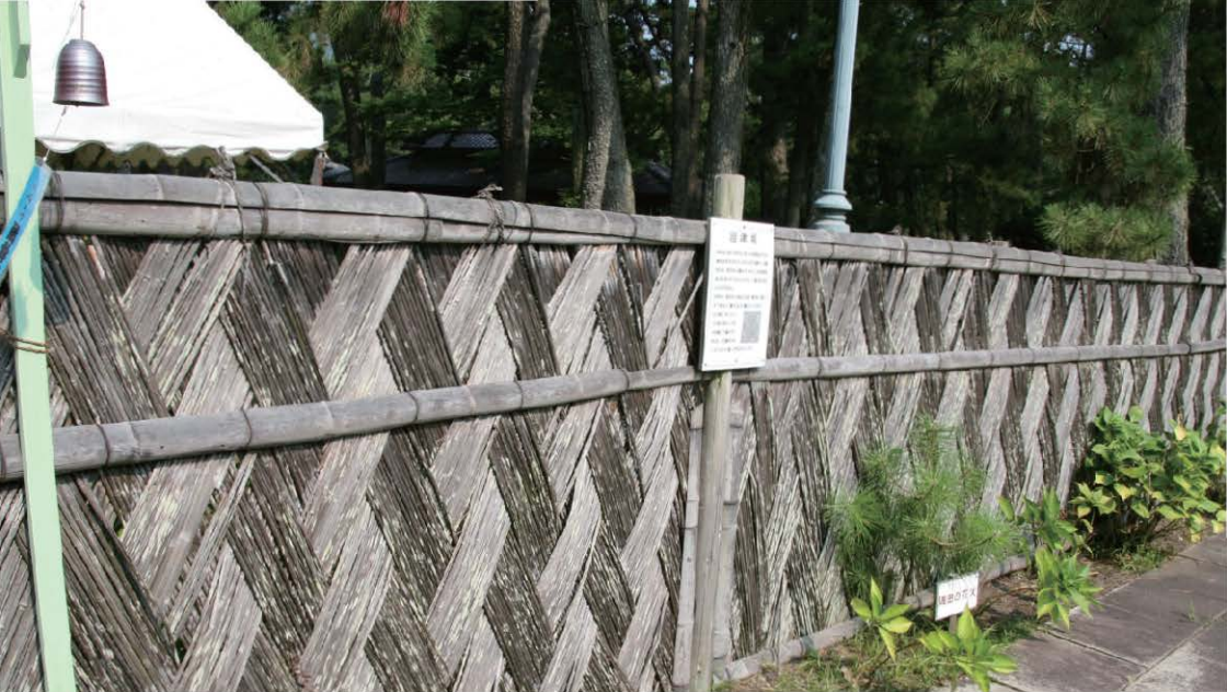
⑬沼津御用邸記念公園の沼津垣（沼津市下香貫島郷、2013年8月、藤井撮影） 沼津周辺の浜の潮風を防ぐために用いられてきた垣根。旧沼津御用邸で多く使われたため、広く知られるようになった。箱根竹と呼ばれる細い籐竹を十数本束ねて、網代編にしている。
