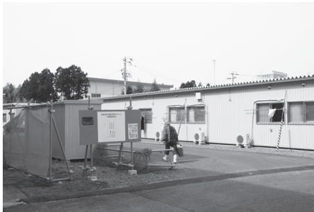
▲写真 42 小学校校庭に設置された仮設住宅（2012年3月撮影）
