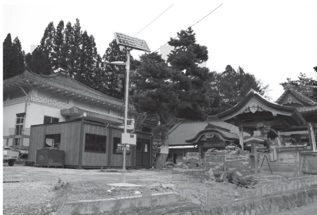
▲写真 32 修復中の盛岩寺（2012年3月撮影）
