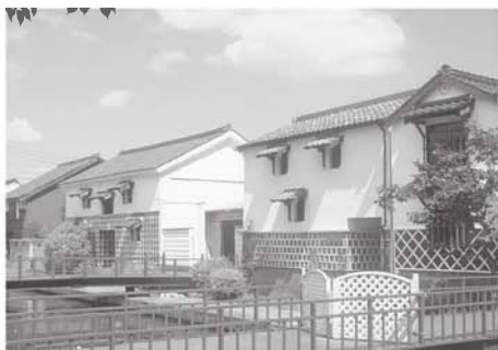
▲図 73 旧加茂川沿いの土蔵群
