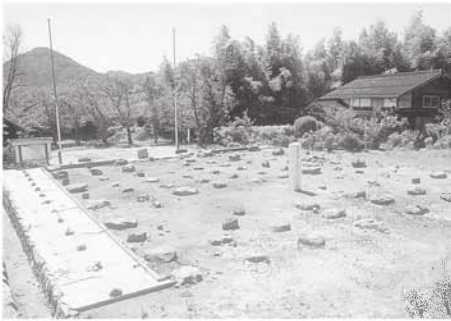
▲図1 隠岐国分寺本堂の焼け跡
