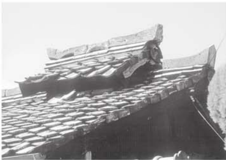
▲図67 出雲市・来待石の棟石（上）とコンクリート製の棟石（右）
