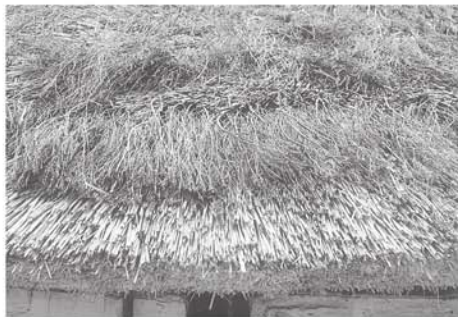
▲図9 ライ麦とヒースの混ぜ葺き
