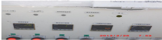
写真2. 本体温度測定箇所 (a: 燃烧室, b. 熱交換出口, c.1 次側温水出口, d. 2 次側温水出口)
