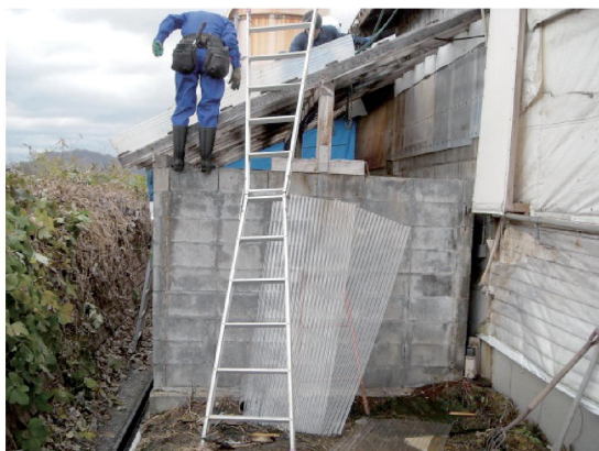
写真2 改修前の脱臭槽外観
