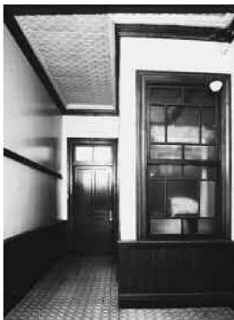
図7-8 : 廊下から事務室方向を見る
