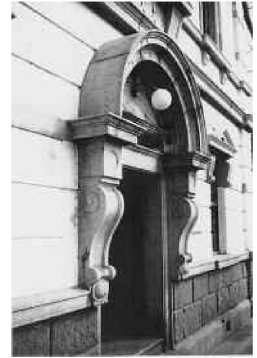
図7-4 : 正面玄関辰野式アーチ庇
