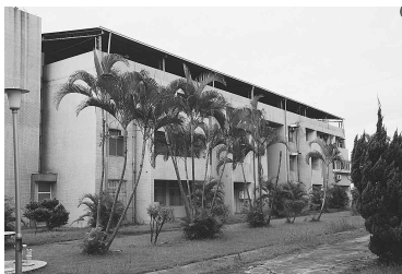
写真5 宿舎棟（二重屋根の外断熱を図っている）
