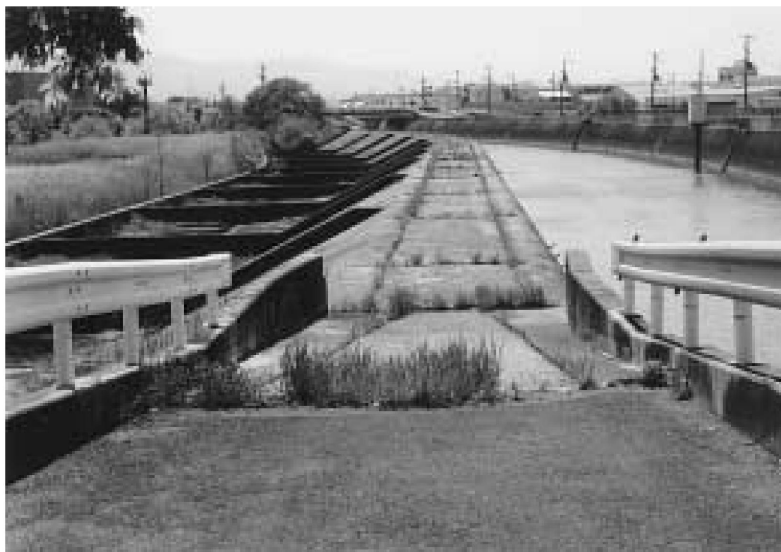
第5図 深北緑地(寝屋川治水公園)における寝屋川左岸の越流堤
