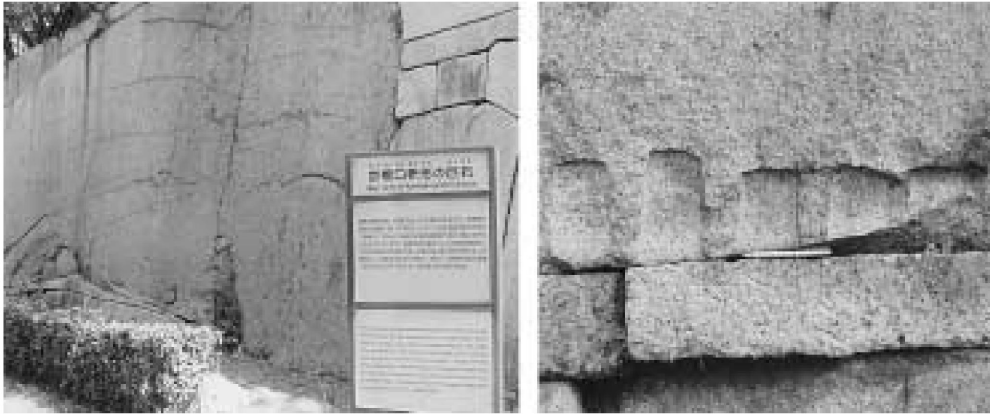
第8図 大阪城京橋口枡形の巨石と石材切り出しのための矢穴
