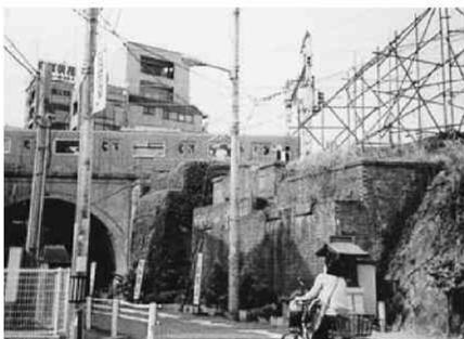
現在のJR西日本大阪環状線の内廻り電車が走行する鉄道橋と、それに併行して隣接する旧大阪鉄道時代のもの（ツタが一面にからみついていて）、および旧関西鉄道時代のものと推定される橋台遺構。（線路南側）
