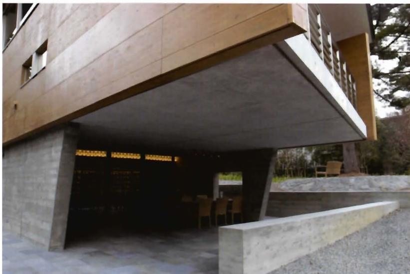
写真10. 約6mの跳ねだし床 下はワインセラー
