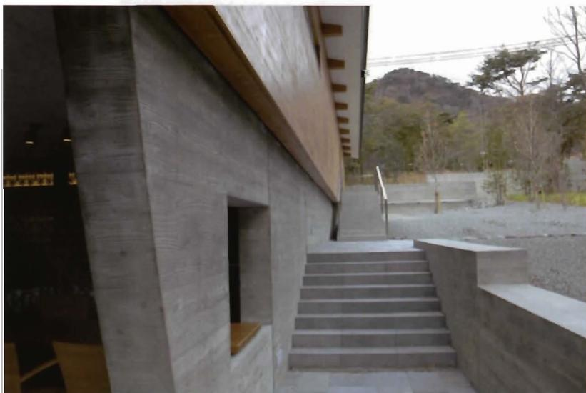
写真11. 下部コンクリート仕上げ 杉板化粧型枠
