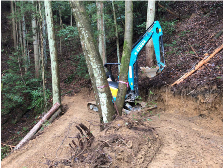
写真1 スイッチバック線形での森林作業道の接続部分とバックホー（京都府綾部市） 注：2018年12月22日に河田撮影
