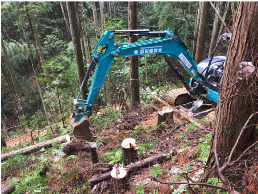
写真2 全切全盛工法での森林作業道作設の様子（京都府綾部市） 注：2018年12月22日に河田撮影
