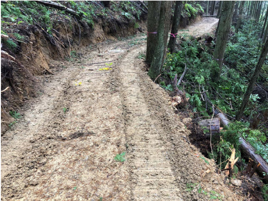
写真3 垂直切土（森林作業道左端）と路肩での表土ブロック積み （右端の路肩部分）（京都府綾部市）
