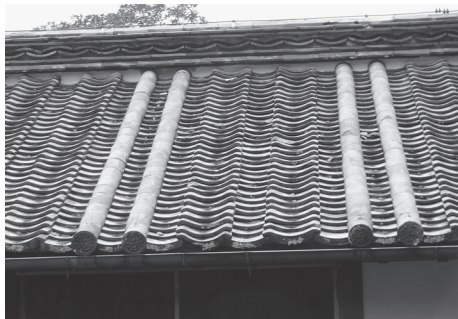
▲図14 背面に古い両袖瓦が葺かれている
