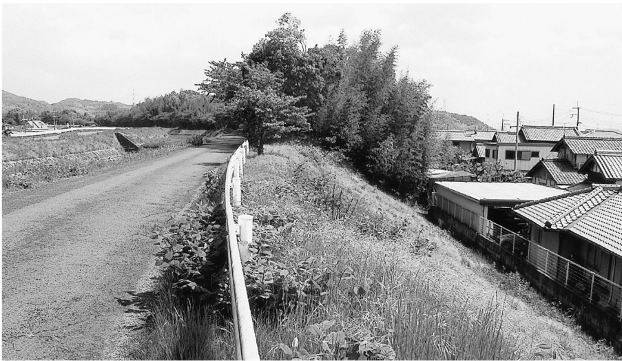
第5図 不動川の堤。奥はかつての堤の面影を残しているが、手前側は全て切り取られている。現在の道路面がかつての河床にあたる。
