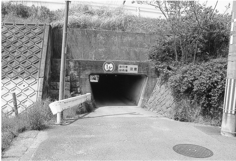
第6図 河川改修後の旧道トンネル。河川改修で河床が切り下げられたため、このような背の低い姿になった。
